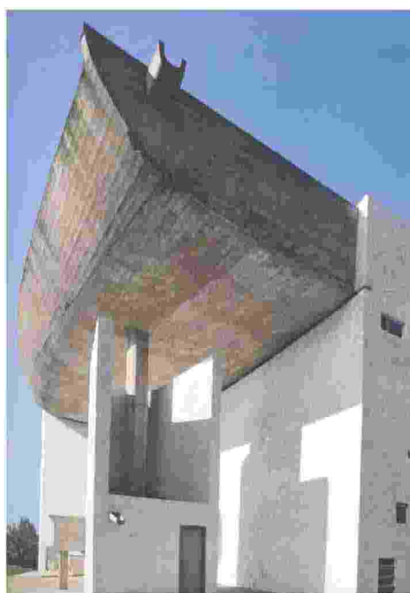
Veduta della cappella di Ronchamp. Sotto una fase della costruzione
